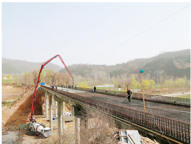
连日来,在徽县柳林镇谢坪大桥建设工地上,机声轰鸣、人声鼎沸,工人们忙着搬运建材、浇灌混凝土,一派繁忙的施工场景。据悉,该建设工程属于危桥改造项目,大桥桥梁全长106m,桥面全宽8.5m,建成后 will 全面打通谢坪村群众出行的“最后一公里”。高琼 摄影报道
